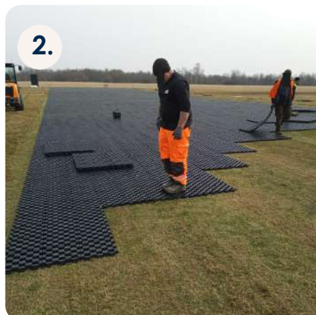
2. Rozłożyć moduły Terra-Grid E ® 35
