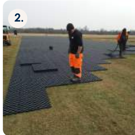
Terra-Grid E® 35 Module auslegen
