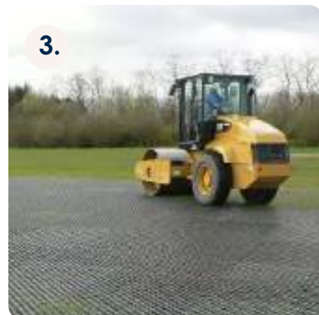
Pevně zatlačte moduly do trávníku
