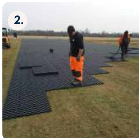
Rozložte moduly Terra-Grid E® 35
