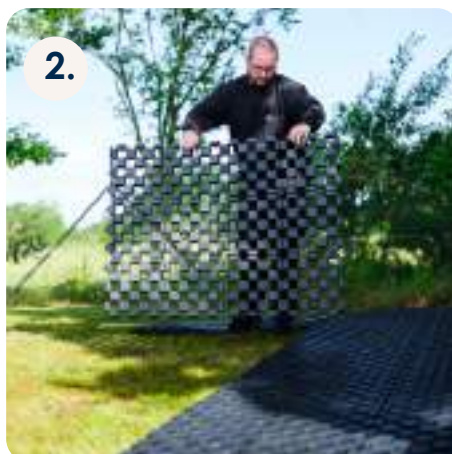
2. Rozložte moduly Terra-Grid E® 35
