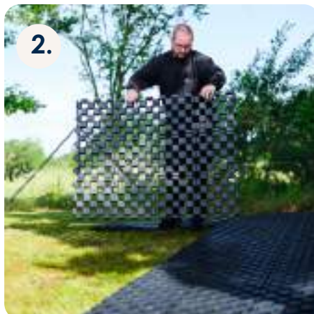
Terra-Grid E® 35 lægges ud
